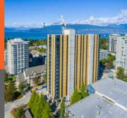
Brock Commons 公寓是温哥华不列颠哥伦比亚大学校园内的一座 18 层学生公寓，于 2017 年完工。一层为混凝土结构，两个混凝土核心筒是楼梯、电梯和管道井。重木构件包括 CLT 楼板、胶合木和平行木片胶合木(PSL)柱。柱网尺寸约为 2.85 米 × 4 米。为减小建筑收缩并便于施工中适时调整，开发了一种新的连接形式。设计团队为了验证设计概念，根据试验结果调整最终设计方案，还建造了一座两层模型建筑。根据对下一版建筑规范要求的预测，该项目的抗震设计采用了比现行规范要求更高的要求。该项目使用预制木构件，施工速度非常快，包括组装预
