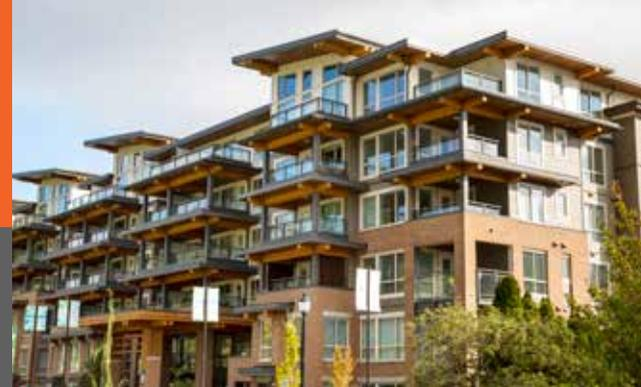
在加拿大不列颠哥伦比亚大学 (UBC) 校区内的 Wesbrook Village 社区兴建了一栋名为 Virtuoso 的多层木结构公寓楼。该项目的开发商是加拿大地产公司 Adera。这座六层高的现代木结构建筑围绕一个中央花园，建在一个两层高的混凝土地下停车库的上部。项目包括 106 个两卧和三卧单元，面积从 130 到 160 平米不等。作为致力于开拓木结构多层公寓市场的开发商，Adera 早前收购了重型预制木结构构件生产和设计公司 Structurlam Products，Structurlam 是一家总部位于 BC 专注于生产 CLT（正交胶合木）和 GLT（板层胶合木产品）的提供木结构设计施工一体化企业。Adera 一直致力于推动木结构建筑在其地产项目中的运用，不断探索木结构在经济，效率和质量的提升，并选择在多户住宅市场探索混合轻木结构 / 重型木结构的可能性。
