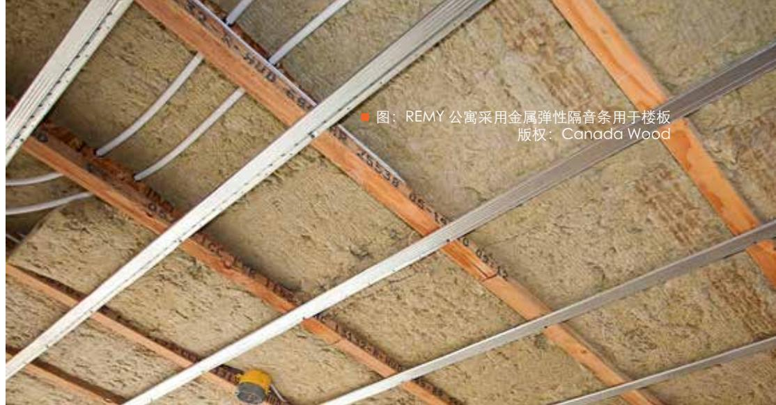
图：REMY 公寓采用金属弹性隔音条用于楼板
