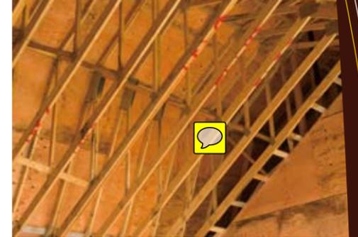
木桁架在建筑屋顶中很多用途，给了设计师在合理成本的基础上拓展更多的建筑美学和性能表现的空间。它们可与木框架墙或钢，混凝土墙方便牢固的连接。设计软件和先进的生产工艺使木桁架预制构建在满足强度要求的同时，能适应各种复杂的屋顶形状。
