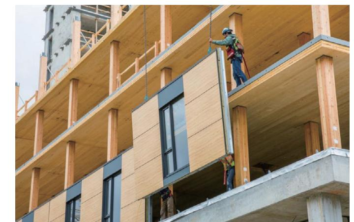
Brock Commons大楼的独特之处在于采用了重型混合木结构体系:底层是混凝土现浇混凝土板柱结构,其上部17层是重型板柱木结构,中部为2个现浇混凝土核心筒从底层贯穿至顶层。该项目技术先进、经济合理,被当地政府授予示范工程称号。同时使用了目前最为先进的工程木材料和建造技术,证明了高层木结构建筑具有更加安全经济、低碳环保的建筑特点。
