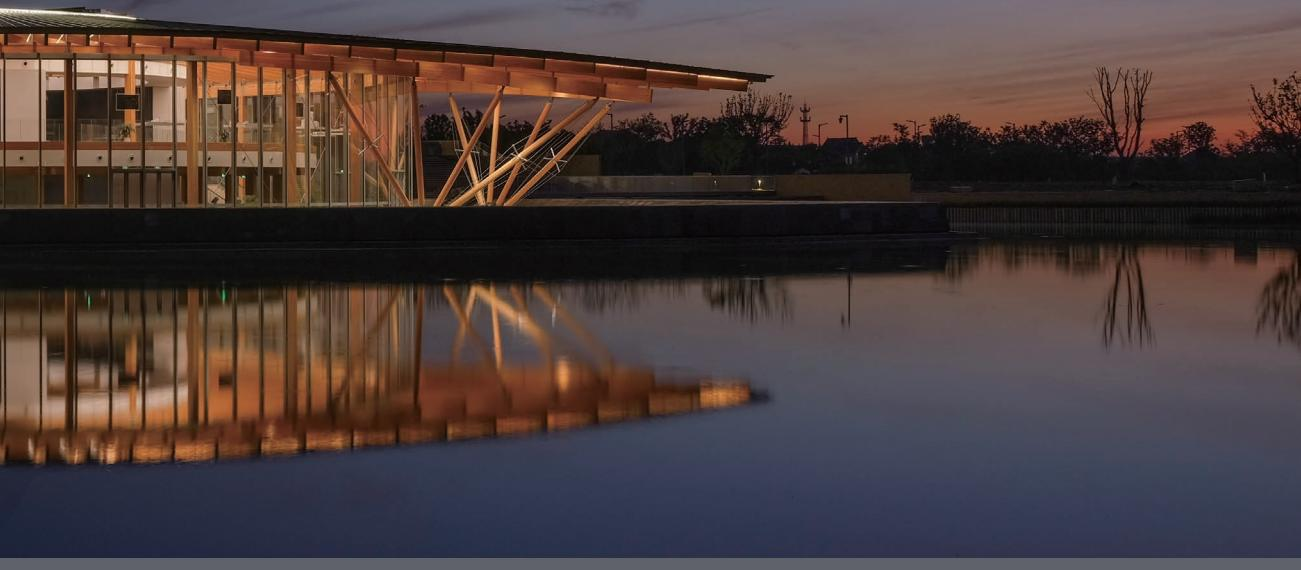
为营造会议室高大空间的建筑效果，结构设计中也配合采用了多种解决木结构大跨空间的方案，包括 10 米通高胶合木柱，张弦胶合木梁，钢木组合桁架等。
