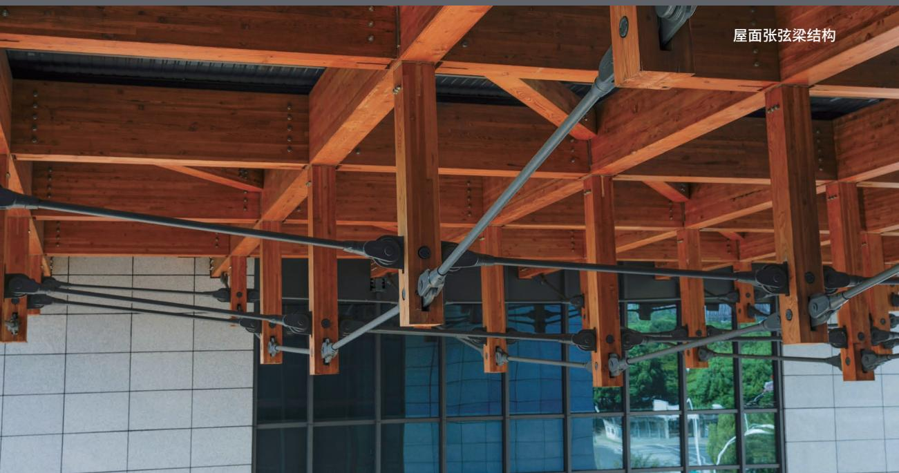
木结构主体框架使用了产自加拿大的花旗松，在国内工厂加工成胶合木构件，并采用自动化生产设备进行切割、打孔和开槽。胶合木构件之间采用钢连接件和螺栓连接。
